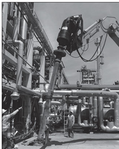
Рис. 1. Строительство в стесненных условиях
