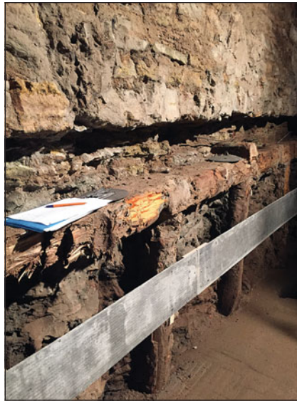
Рис. 16. Вид грунтоцементной конструкции, изготовленной под подошвой бутового фундамента на деревянных лежнях и сваях (кузница, ансамбль «Новая Голландия»)
